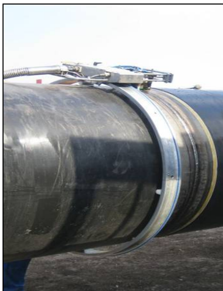
Abbildung 12: Prüfen der Schweißnähte : Ultraschall- / Durchstrahlungsprüfung
