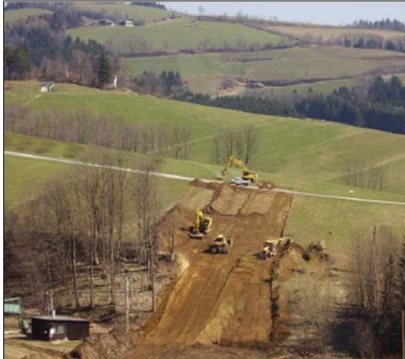
Abbildung 9: Trassenvorbereitung, Oberbodenabtrag
