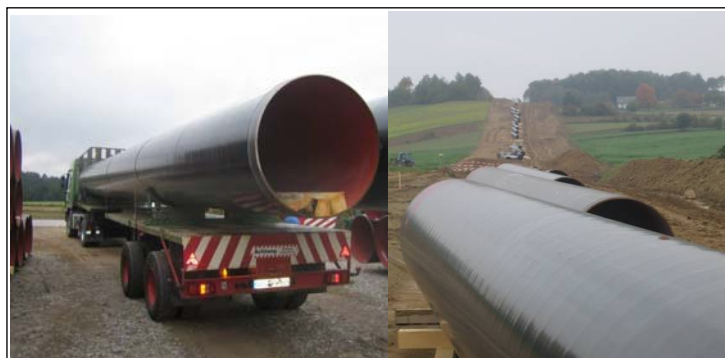
Abbildung 10: Ausfahren der Rohre
