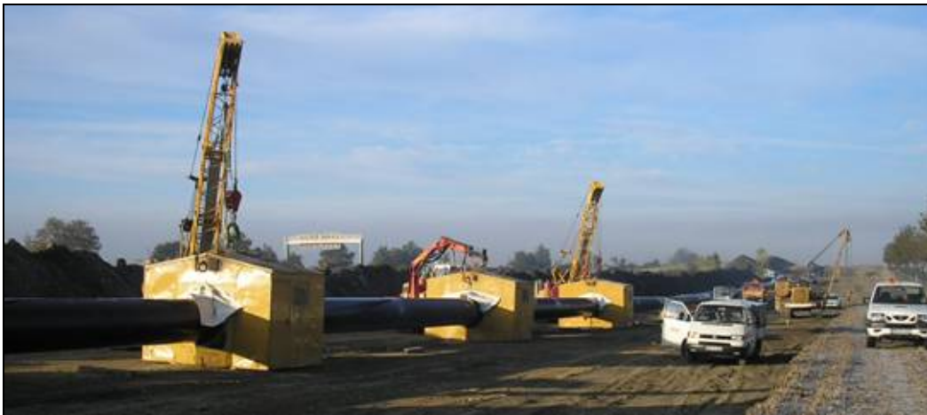
Abbildung 11: Verschweißen der Einzelrohre zum Rohrstrang
