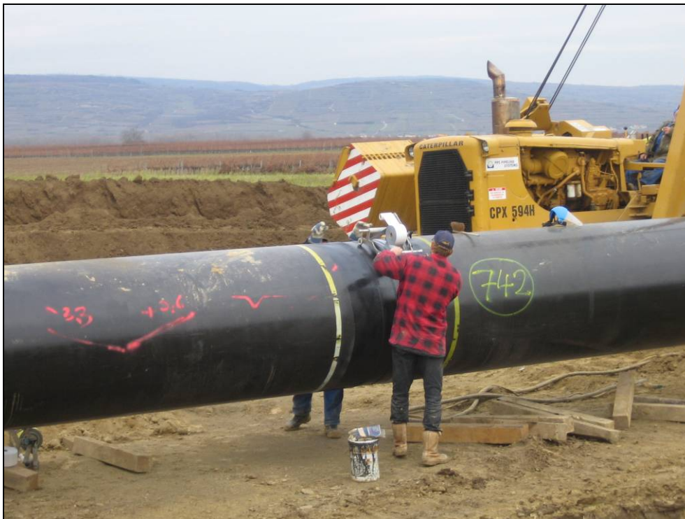
Abbildung 13: Nachumhüllung der Rohre
