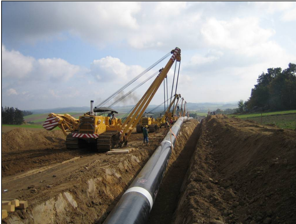
Abbildung 15: Absenken des Rohrstrangs
