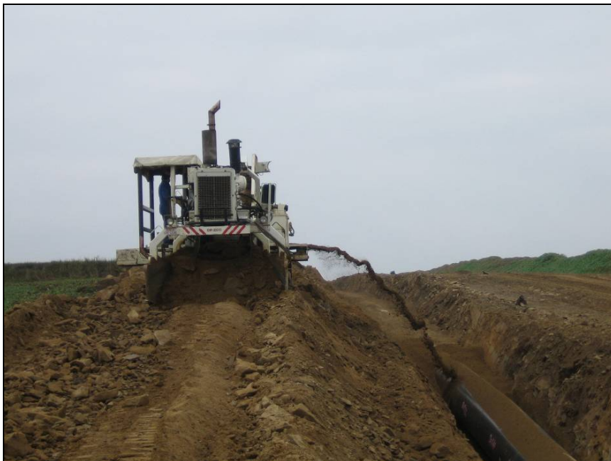
Abbildung 16: Verfüllen des Rohrgrabens
