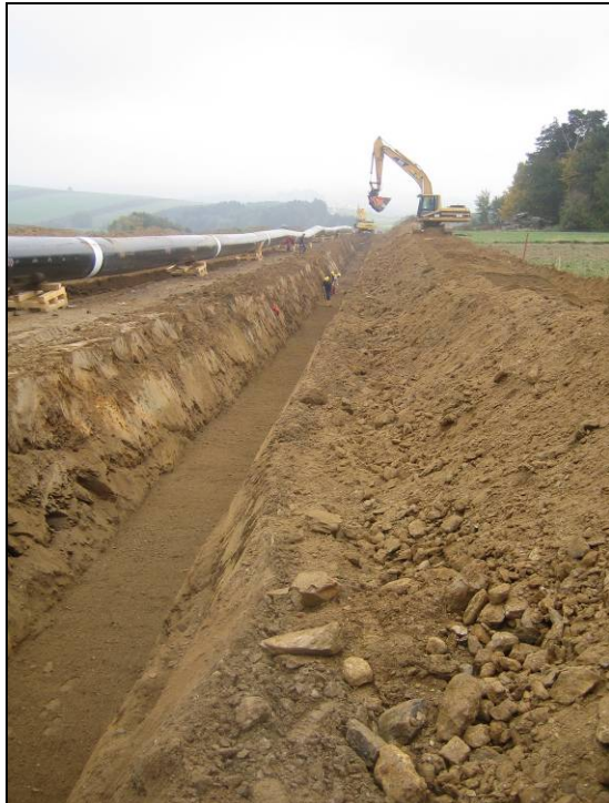
Abbildung 14: Rohrgrabenaushub
